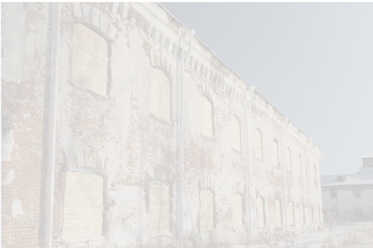
Александровский централ после проведения первоочередных противоаварийных работ
