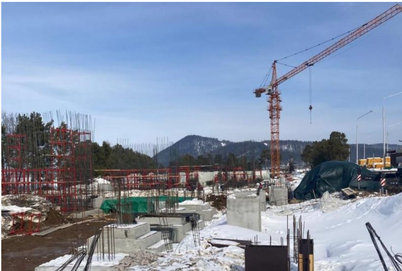
Строительство Green Flow Baikal
