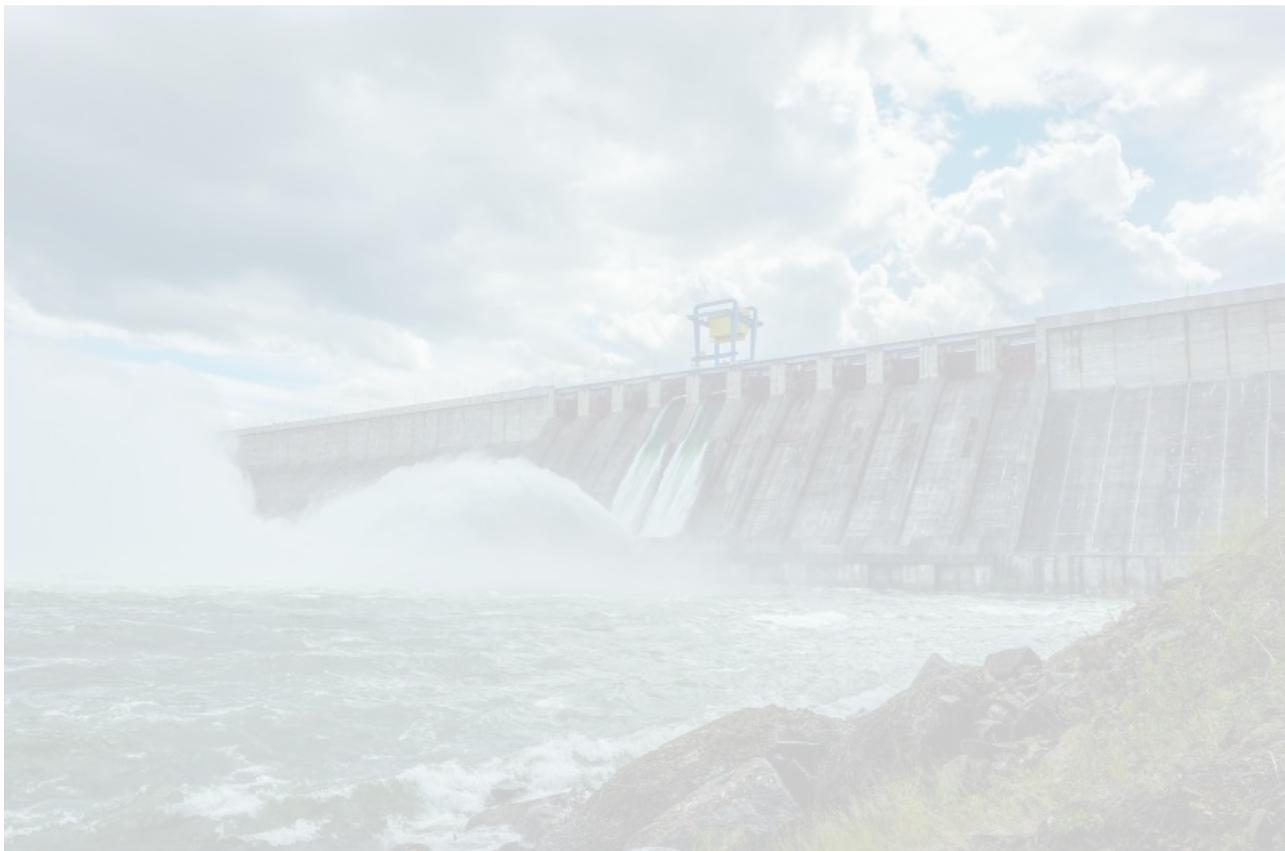
При строительстве ГЭС было использовано 4,58 миллиона кубометров бетона. Длина плотины составляет 1475 метров, а высота – 105 метров. На самой станции установлены 16 гидроагрегатов радиально-осевого типа мощностью 240 МВт каждый.
