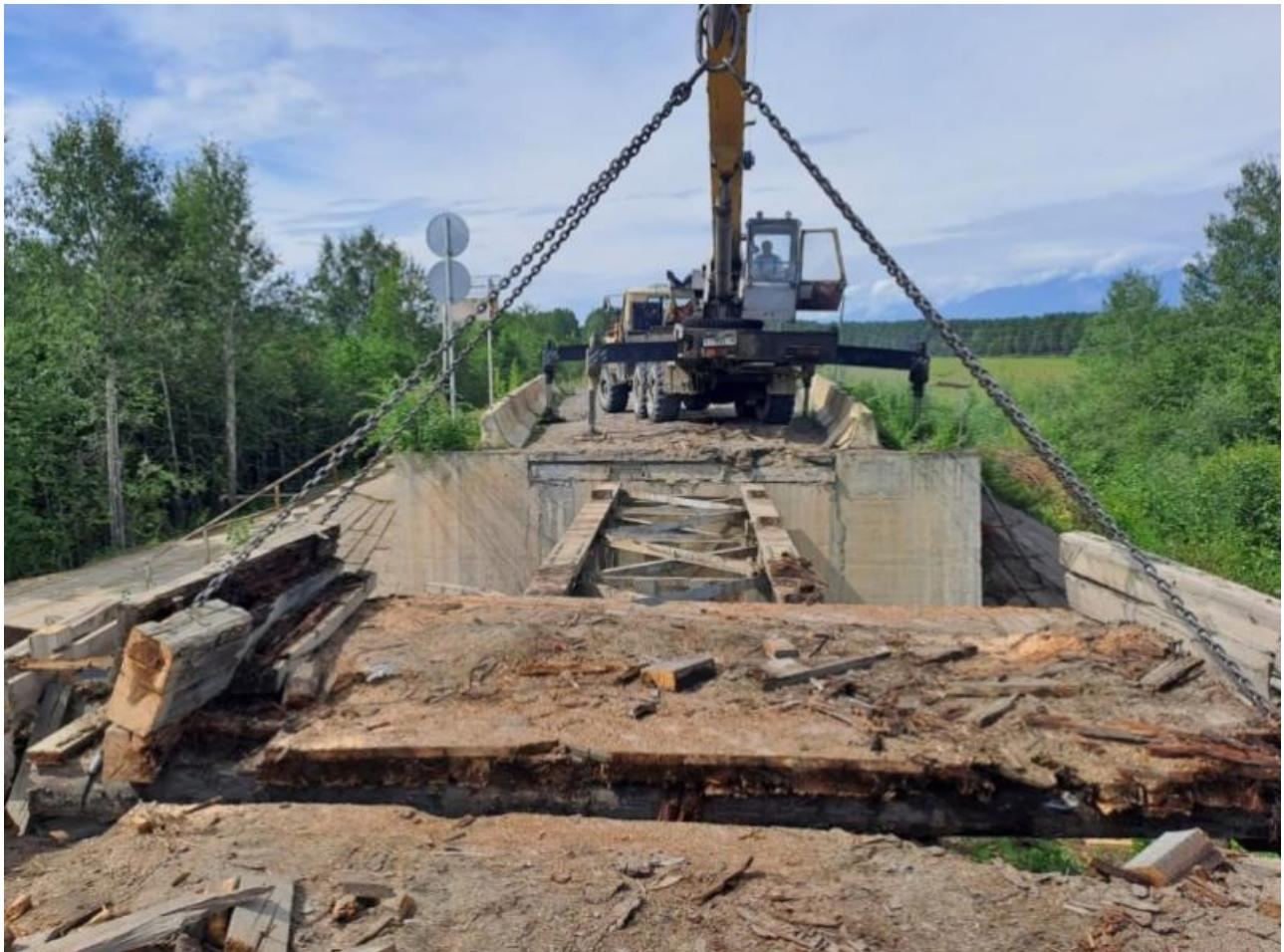
Капремонт начался в прошлом году в рамках нацпроекта «Безопасные качественные дороги». Подрядчик успешно завершил первый этап работ – построил временный мост, устроил подъезды и демонтировал деревянные пролетные строения на объекте. Отставаний от графика нет.
