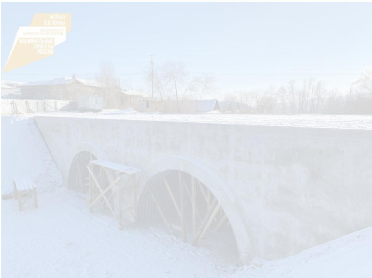
Подрядчик уже демонтировал старый аварийный мост, установил опоры, возвел арочные конструкции, забетонировал порталные стенки, собрал трубы и отсыпал основу дорожного полотна. Теперь ему предстоит уложить дорожное полотно, установить освещение и ограждения, а также устроить тротуары. В эксплуатацию мост введут в этом году.
