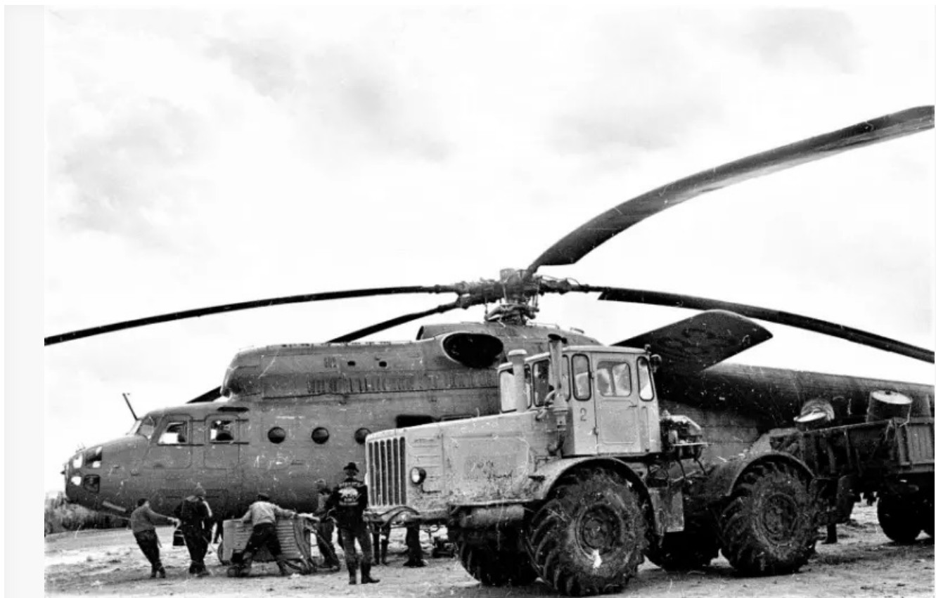
Ми-6 и К-700 на строительстве БАМ
