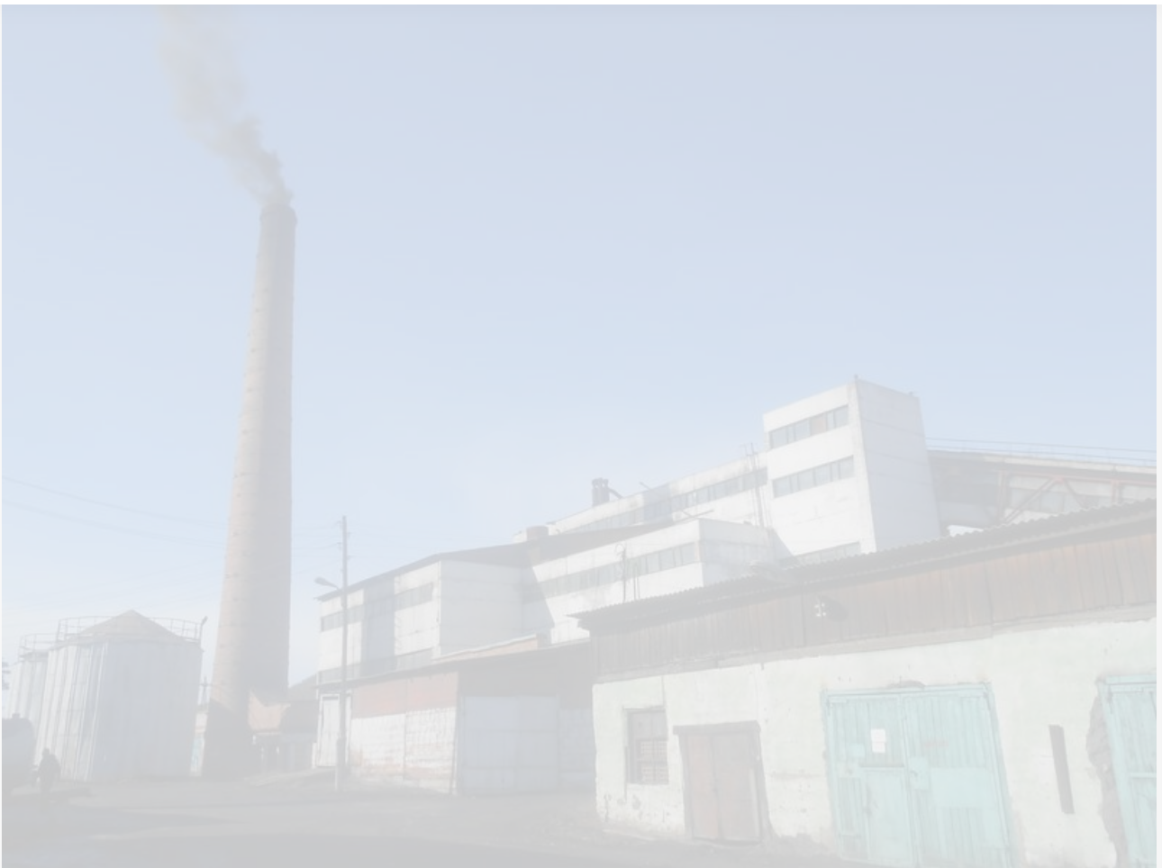
Центральная Котельная МУ МОП ЖКХ «Заиграево»
