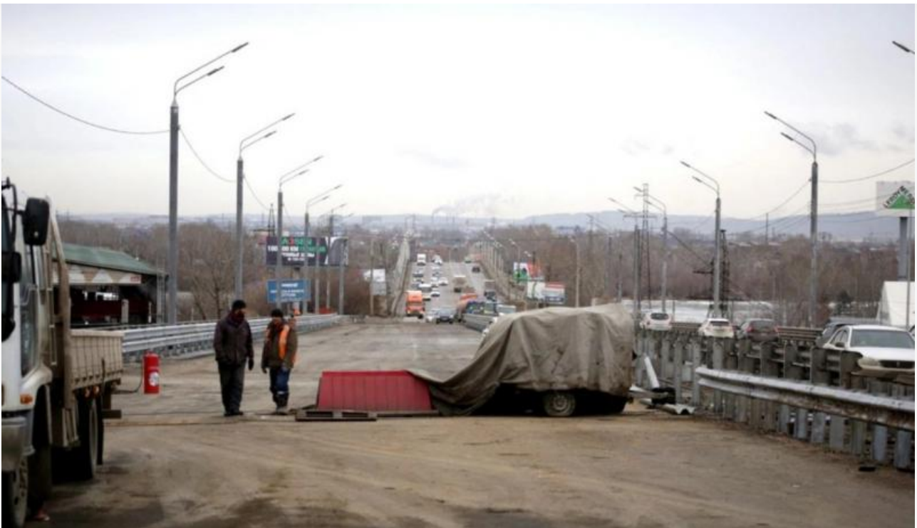
Фото путепровода на Джамбула сделаны 20 ноября
