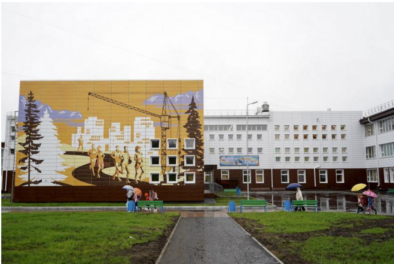
Жилые комплексы, построенные СПМК-7 в Иркутске
