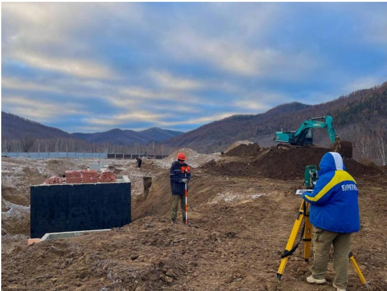
Модернизация стартовала в мае. Рабочие построили два железобетонных резервуара емкостью 125 кубометров и насосную станцию, проложили магистральные сети. Сейчас они заняты гидроизоляцией и теплоизоляцией насосной станции, а также подготовкой резервуаров к гидравлическим испытаниям.
