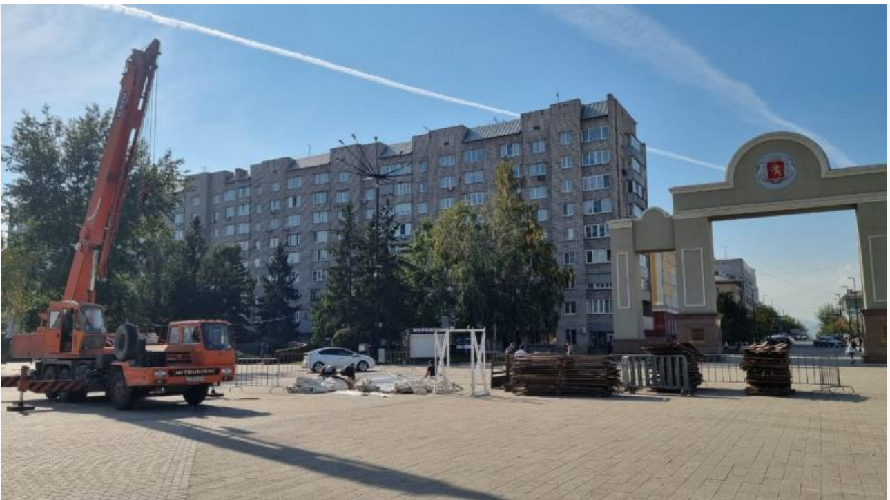
На площади уже начались работы.
