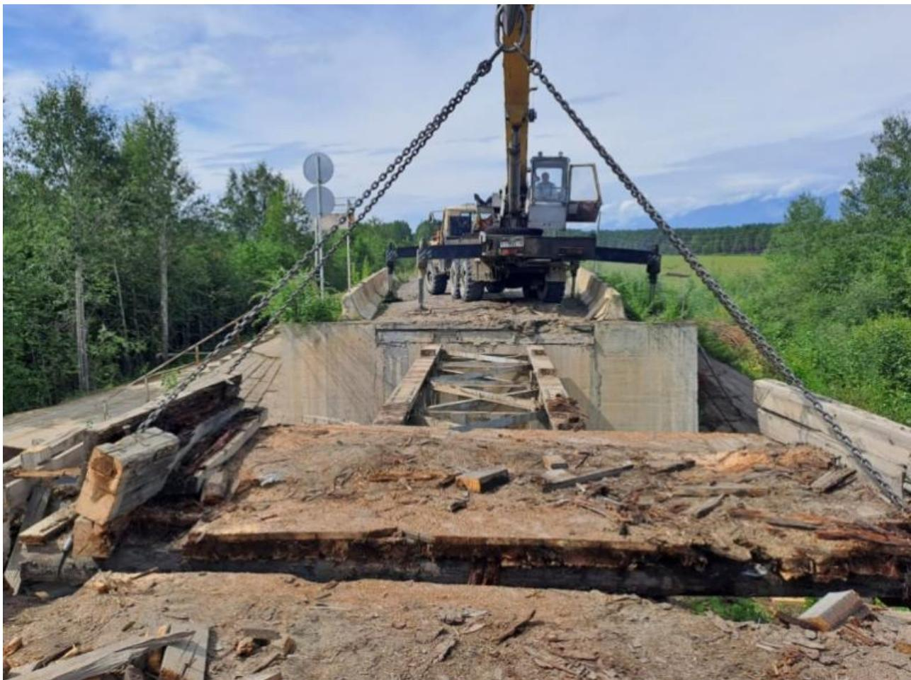
Работы обойдутся в 53,5 миллиона рублей. Их проведут в два этапа: на этот год запланированы бетонирование, покраска металлоконструкций и заготовку материала для укладки верхнего настила моста, на следующий - монтажные работы и обустройство подъездов к мосту. Отставаний от графика пока нет. Ежедневно на объекте трудятся 11 мостовиков и специальная техника.
