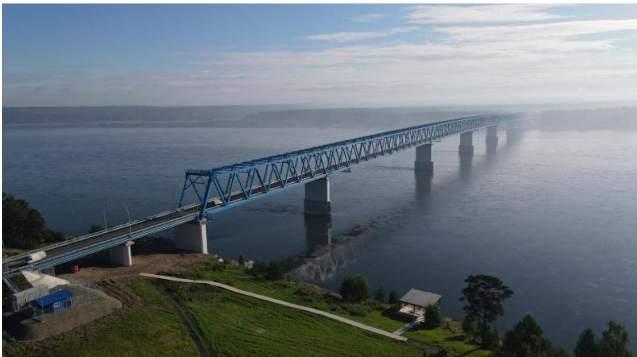
Мост находится рядом с поселком Высокогорский в Енисейском районе. Его строительство началось в конце 2020 года. Стоимость проекта вместе с подъездами составила около 10 миллиардов рублей. Протяженность моста – 1,2 километра, вес пролетов – 8 тысяч тонн. Сама дорога двухполосная, автомобили будут двигаться по ней со скоростью около 80 километров в час.
