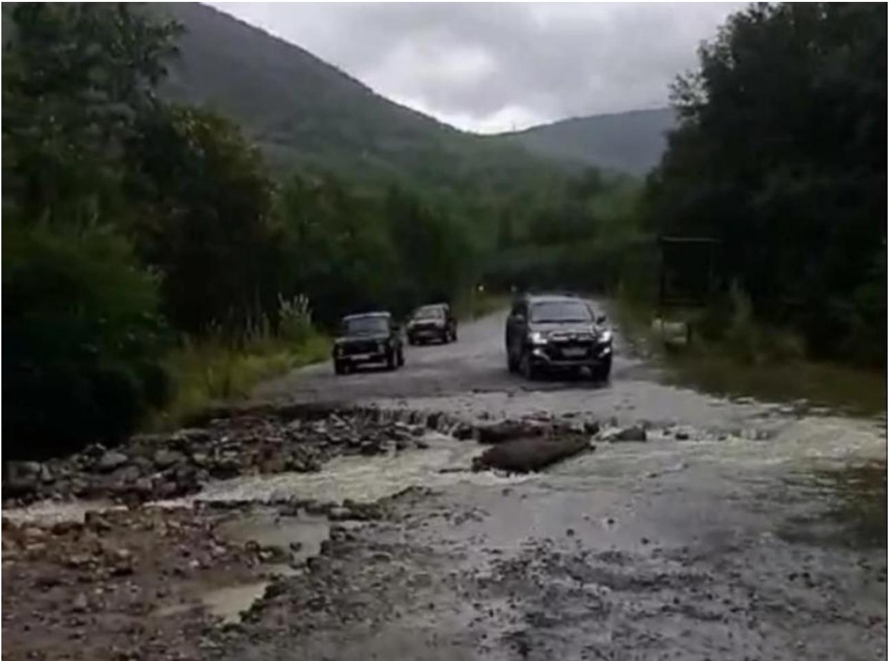
Подмыт участок трассы «Усть-Кут — Уоян» на 278-м километре. Там работает тяжёлая техника. Закрыто движение на 265-м километре той же трассы, подмыты подходы к мосту через реку Кунерма. Вода в реке прибывает, на месте также работает тяжёлая техника.
