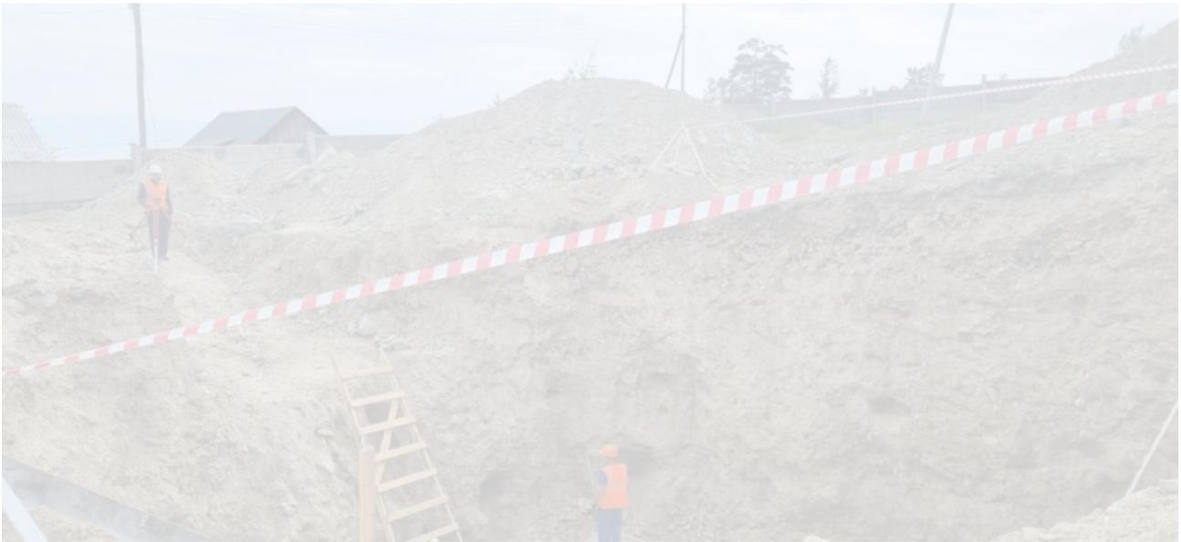
Отмечается, что на объекте выполнили устройство бетонной подготовки, фундаментных железобетонных плит и земляные работы. Также привезли материалы и оборудование из Красноярска. Сейчас подрядчик занят устройством фундамента насосной станции и водопроводных колодцев, прокладкой труб с установкой запорной арматуры и фасонных частей.
