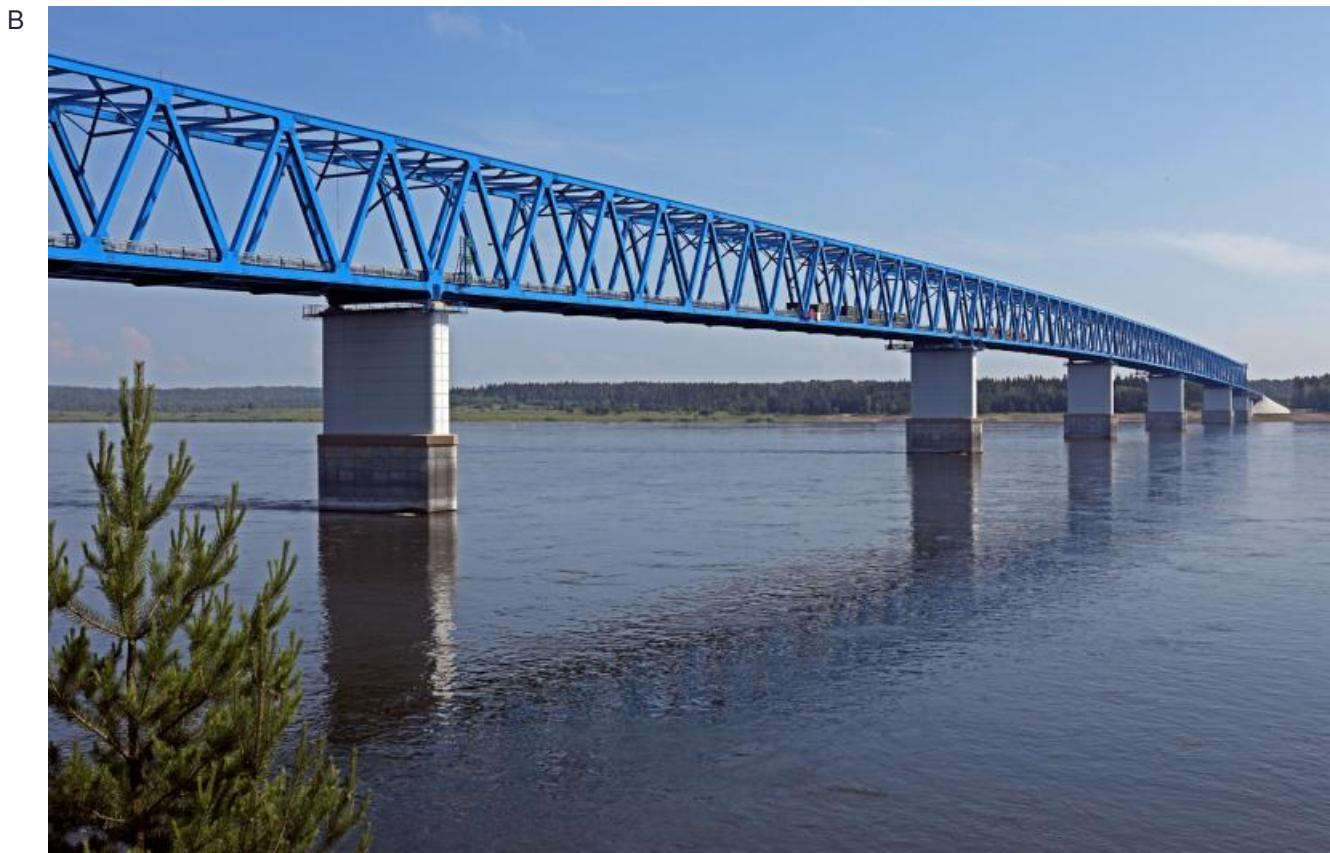
начале июля на мосту провели комплексные предпусковые испытания, в ходе которых проверили состояние всех элементов переправы. Для тестирования на статику и динамику использовались большегрузные самосвалы массой в 35 тонн. По результатам испытаний эксперты выдали положительное заключение о готовности моста к эксплуатации.
