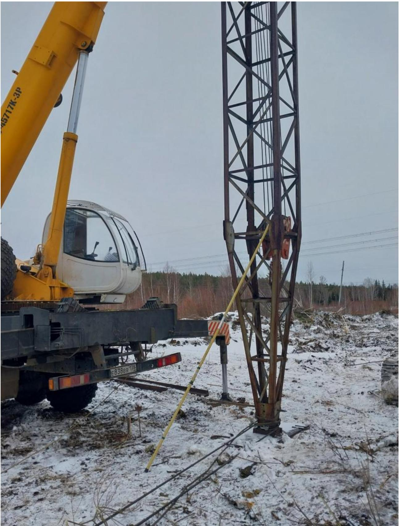
марте этого года энергетики обследовали линии электропередач и уже укрепили фундамент опоры на линии электропередачи 500 кВ «Братская ГЭС – Тулун», которая обеспечивает транзит электроэнергии и связывает всю энергосистему региона. Эта магистральная линия частично проходит по болотистой местности, из-за особенности грунта может происходить выдавливание фундамента. Плановый осмотр в прошлом году позволил вовремя выявить возникший дефект и приступить к его устранению.
