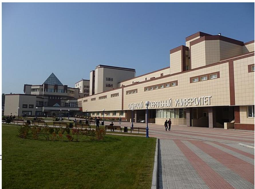
После сдачи у здания обнаружили дефекты: в монолитном перекрытии нарушилась целостность, на перегородках появились трещины. Техническое обследование показало, что при строительстве подрядчики использовали некачественные материалы, в том числе бетон и арматурные стержни. Конструкции находятся в аварийном состоянии, пользоваться зданием нельзя.
