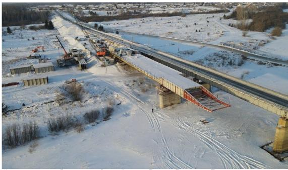
Железобетонный мост через реку Яя на автомобильной дороге Больше-Дорохово – Тегульдет протяженностью 248 метров был возведен в 1976 году, несколько лет назад он начал разрушаться. Старый железобетонный мост работает сейчас в реверсивном режиме: скорость движения транспорта общей массой до 15 тонн ограничена до 30 километров в час. С ноября 2018 года для движения большегрузов действует также временный понтонный мост грузоподъемностью до 80 тонн.
