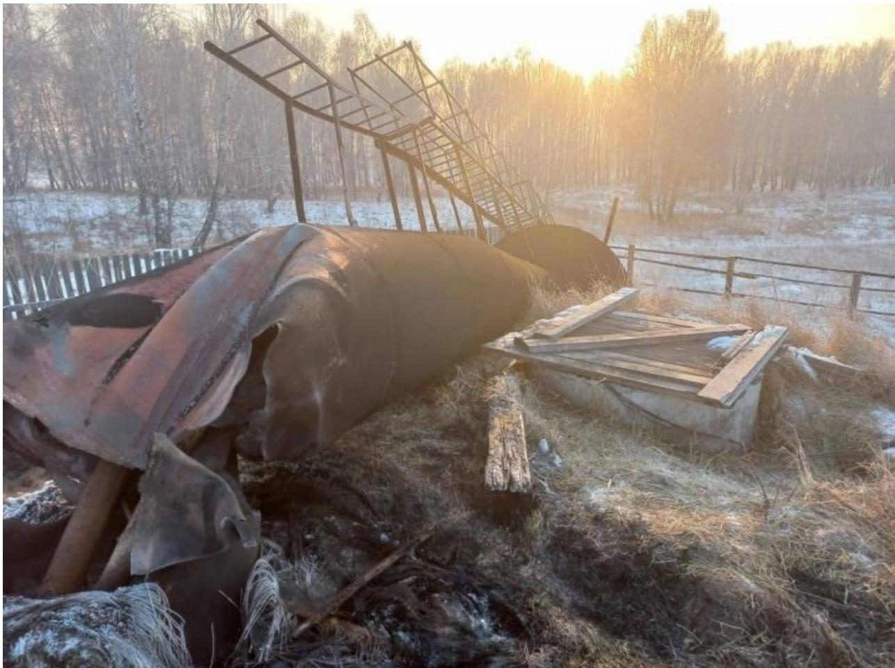
В системе подачи воды башни на улице Ленина образовалась наледь. Рабочие начали отогревать замёрзший участок, но металлическое основание башни не выдержало, накренилось, затем башня рухнула полностью.
