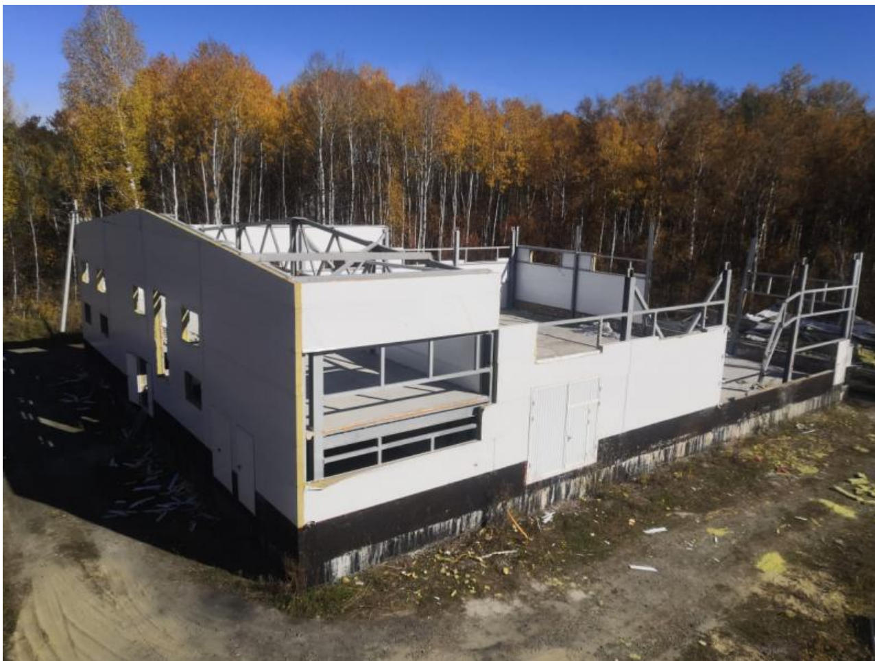
Фото: прокуратура Новосибирской области
