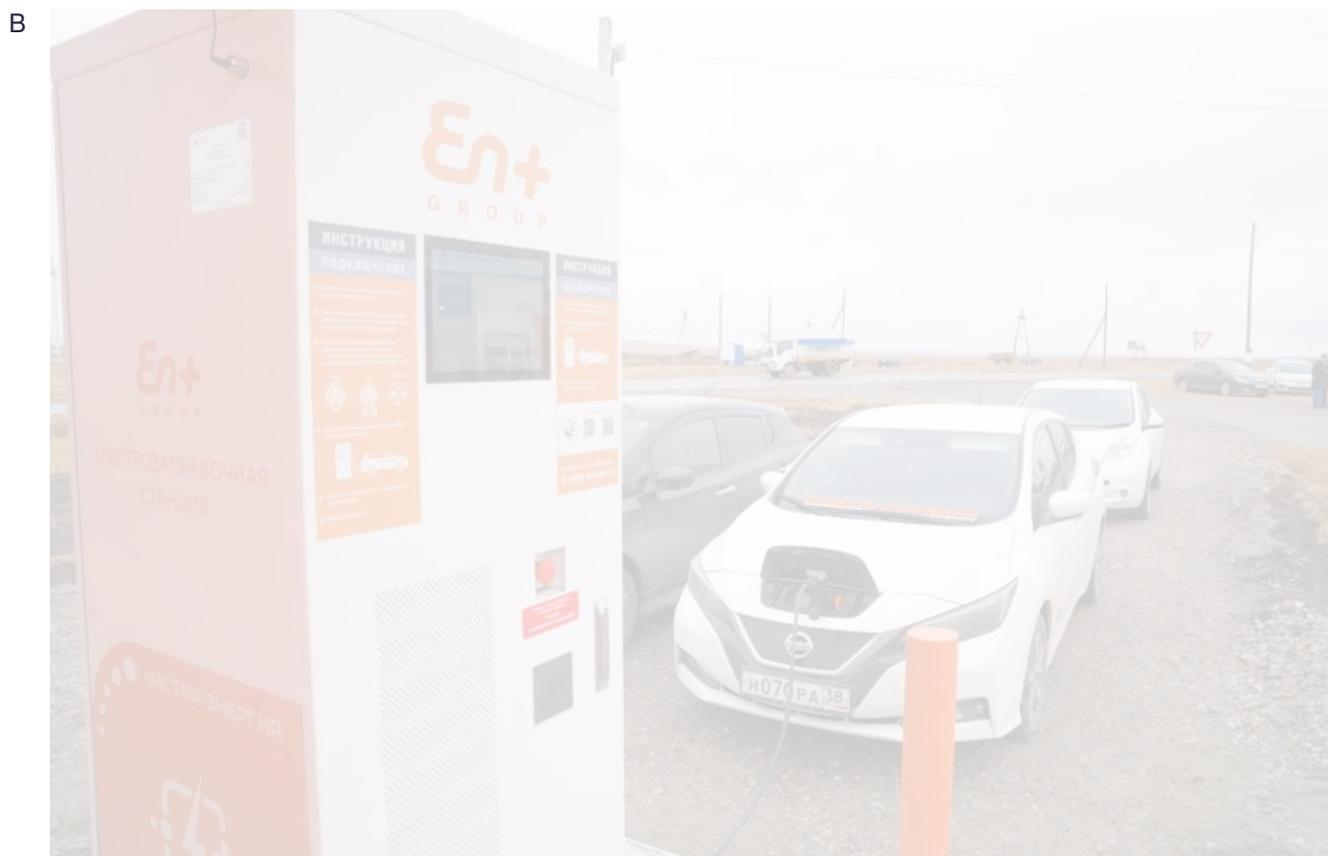
Усть-Ордынском расположилась станция мощностью 50 кВт, в Баяндае и Еланцах – по 100 кВт. Одновременно на них могут обслуживаться по два авто в режиме быстрой зарядки. Например, для заполнения на 80% аккумулятора самого популярного электромобиля региона Nissan Leaf потребуется примерно 20 минут.
