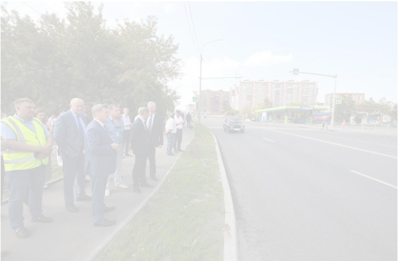
Протяженность нового участка дороги составляет 460 метров – четырехполосное движение, тротуары с двух сторон и полностью переделанное дорожное покрытие. Также была проложена ливневая канализация протяженностью 570 метров. Стоимость дорожных работ составила 90 миллионов рублей.
