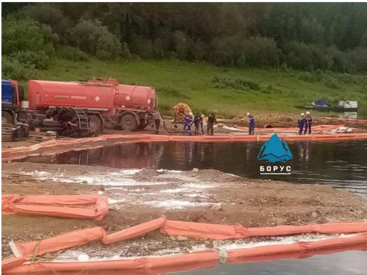
Сообщается, что трубопровод принадлежит компании «Славнефть-Красноярскнефтегаз». Специалисты пытаются устранить последствия разлива: на реке установили боновые ограждения, место происшествия обрабатывают сорбентом.
