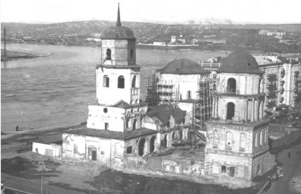
Богоявленский собор, 1968 год. Перед началом реставрационных работ.
