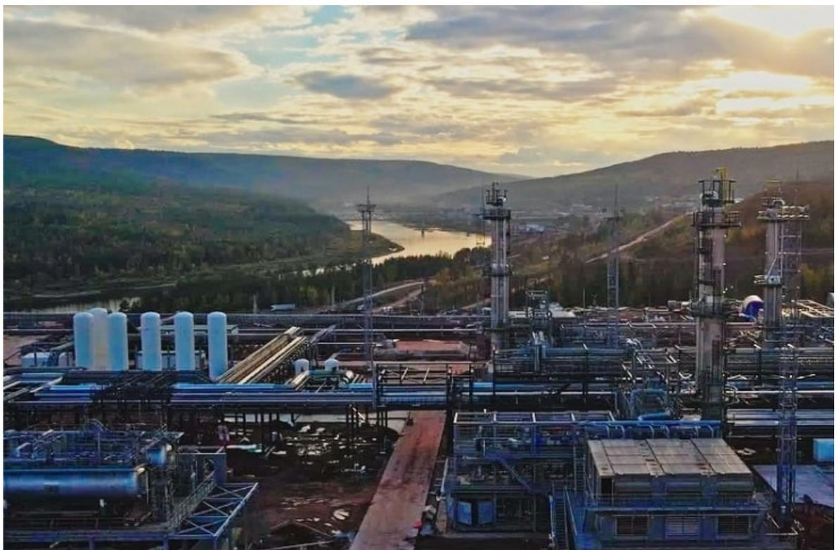
газоперерабатывающий завод является частью масштабного газового проекта ИНК. Объект включает в себя газофракционирующую установку и комплекс приема, хранения и отгрузки сжиженных углеводородных газов и стабильного газового конденсата.
