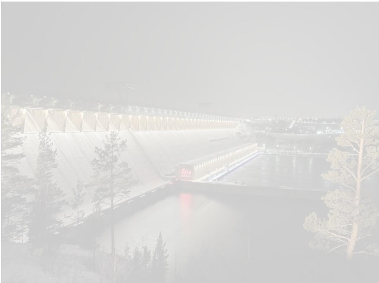
Новая подсветка появилась на бетонной плотине станции, здании ГЭС и панно «Покорение Ангары». Три сотни светильников были смонтированы на высоте пятиэтажного дома и закреплены при помощи специальных химических ампул – анкером, что позволило не задействовать бетон. Тысяча братчан и гостей города смогли увидеть иллюминацию со смотровой площадки. В праздничной церемонии приняли участие руководитель энергетического бизнеса компании En+ Group Михаил Хардинов и мэр города Братска Сергей Серебренников.
