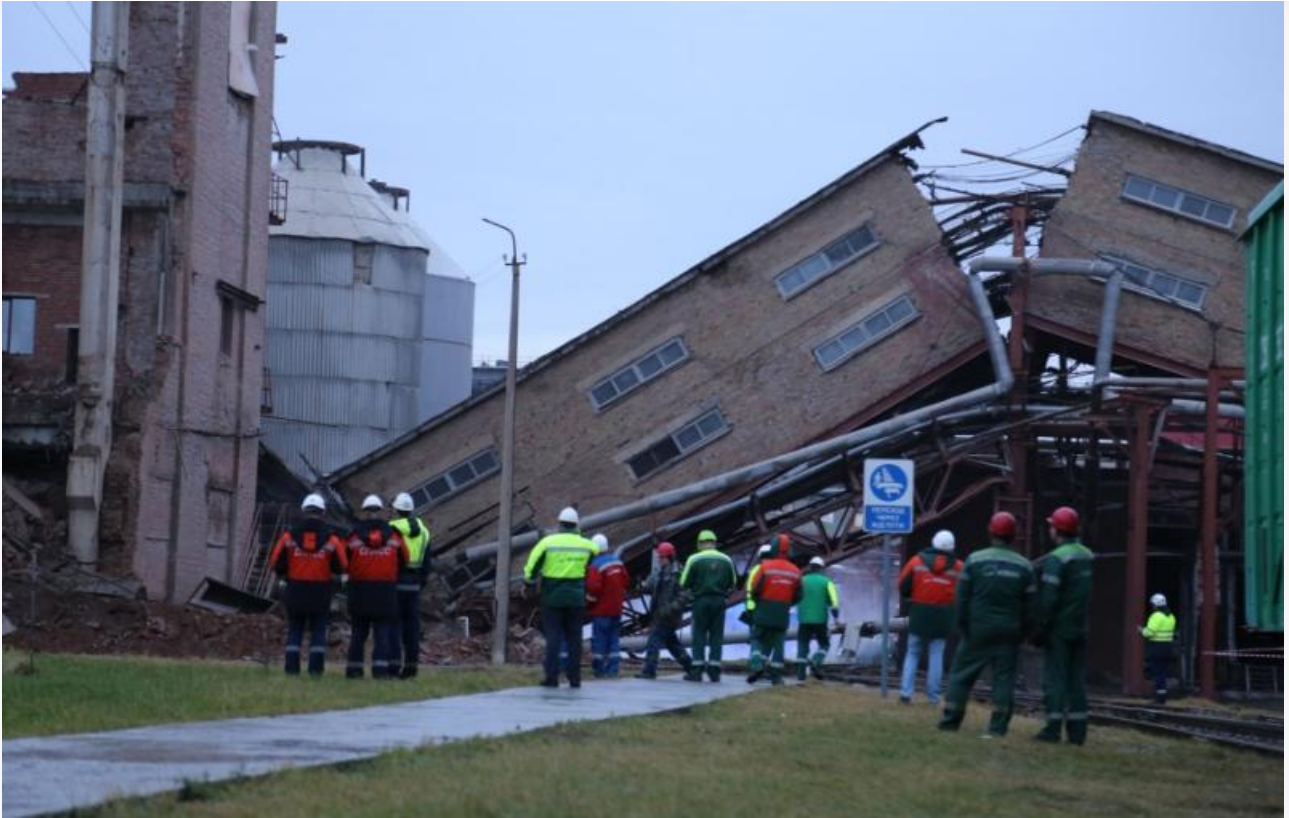
А это в Коряжме на ЦБК стена обрушилась на галерею подачи щепы, октябрь 2018-го.
