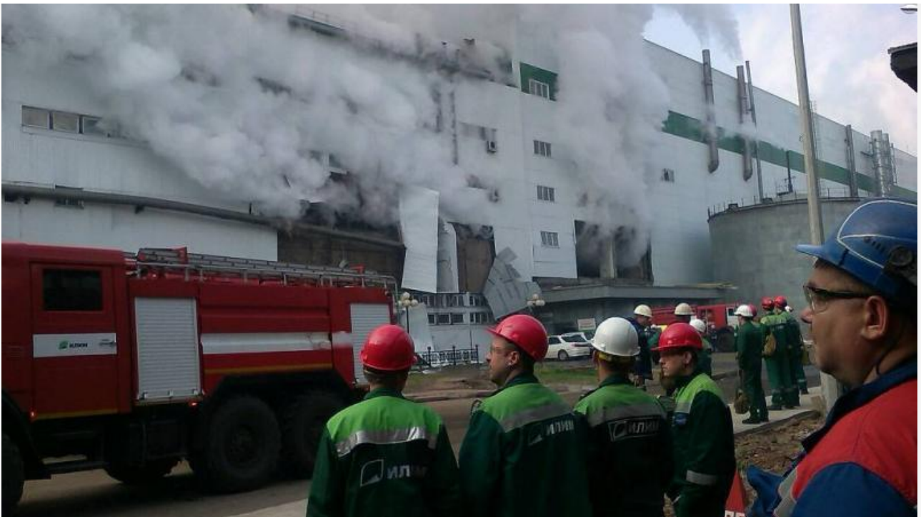
Разрыв паропровода на БЛПК в сентябре 2014-го
