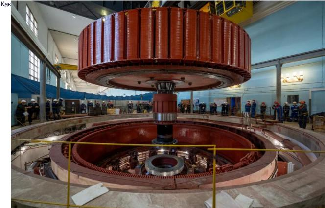
сообщили в пресс-службе En+ Group, при изготовлении ротора были использованы современные, более прочные и эффективные виды стали. За счёт изменения конструкции и применения современных материалов увеличится надёжность и коэффициент полезного действия оборудования станции. Существенно вырастет и мощность всего гидроагрегата: с 82,8 МВт до 107,5 МВт.
