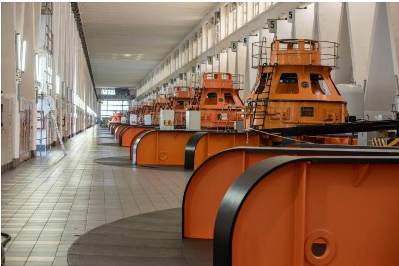
время второго этапа модернизации на Братской ГЭС, с 2014 по 2017 годы, были заменены еще 6 рабочих колес на гидроагрегатах №№ 6-10 и №12. Все 12 новых рабочих колёс на Братской ГЭС, установленные в ходе первых двух этапов проекта, уже подтвердили улучшенные характеристики с повышенным КПД и обеспечили дополнительную выработку электроэнергии без увеличения расхода воды.
