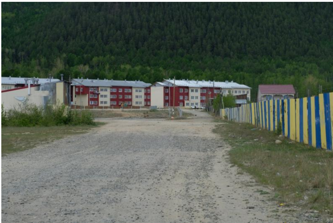
Слева от дороги закрытое здание очистных, справа — забор аэродрома. Фото от 9 июня 2021 года
