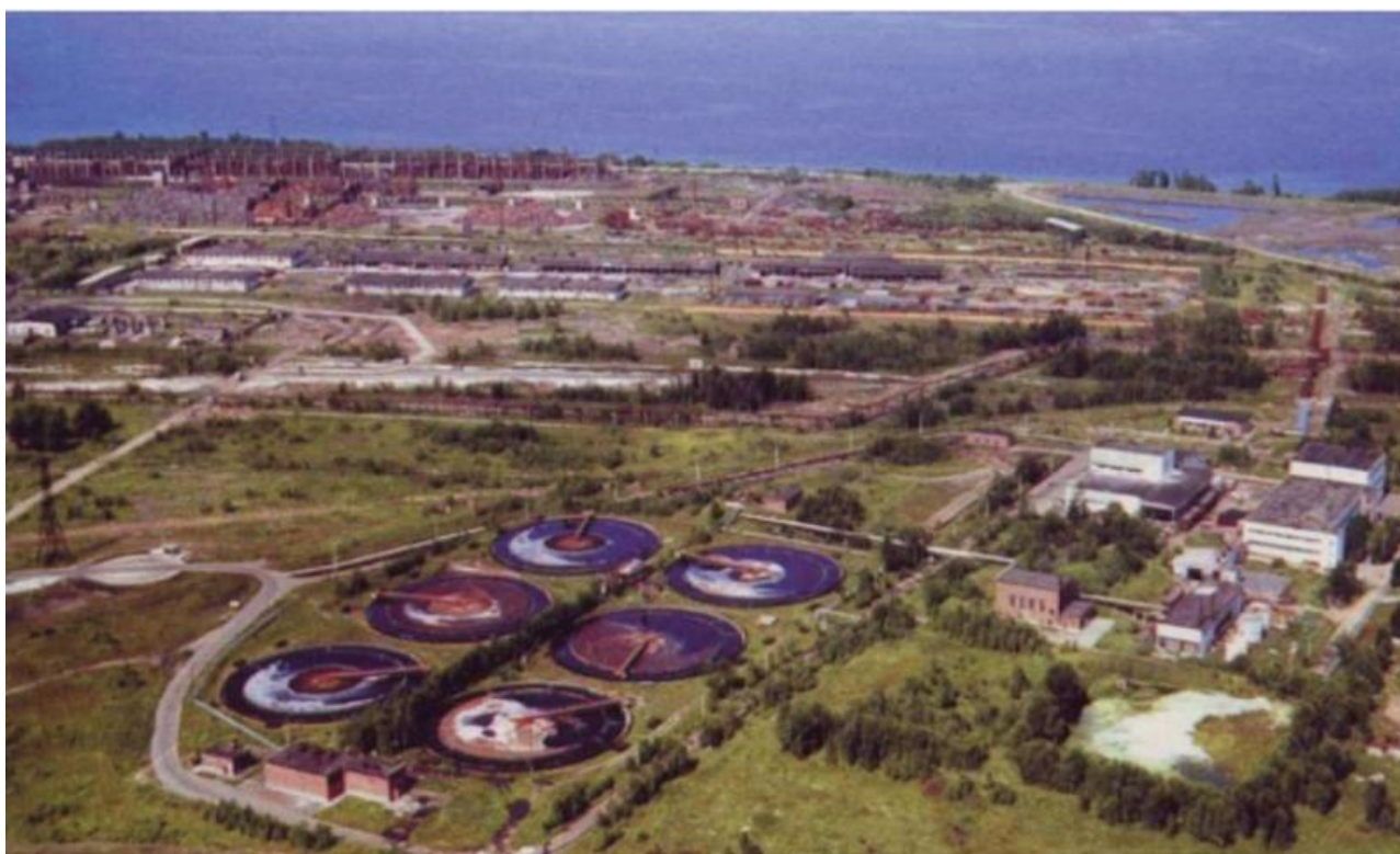
Рис. 2. Очистные сооружения БЦБК. Фото В. А. Короткоручко
