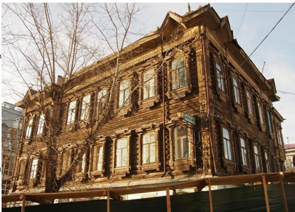
экспертизу, собрали каркас пристроек кровли, провели обшивку пристроя, установили водосточные трубы, сделали устройство ограждений кровли, установили дымники, двери, окна, декор, провели ремонт системы газоснабжения и отопления, покрасили фасад.
