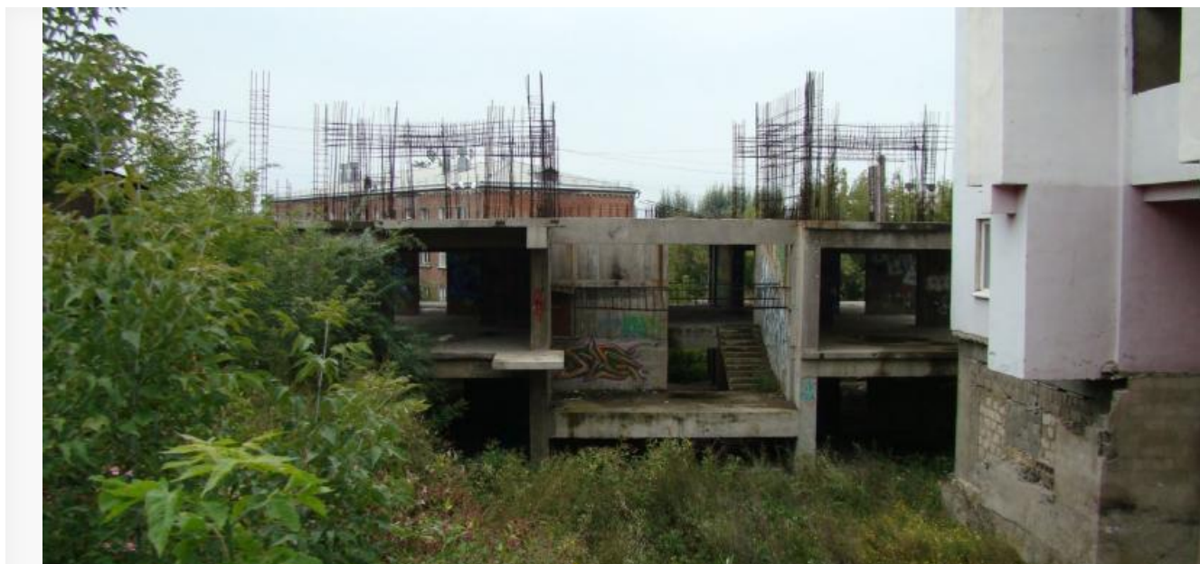
Недострой на улице Сибирской
