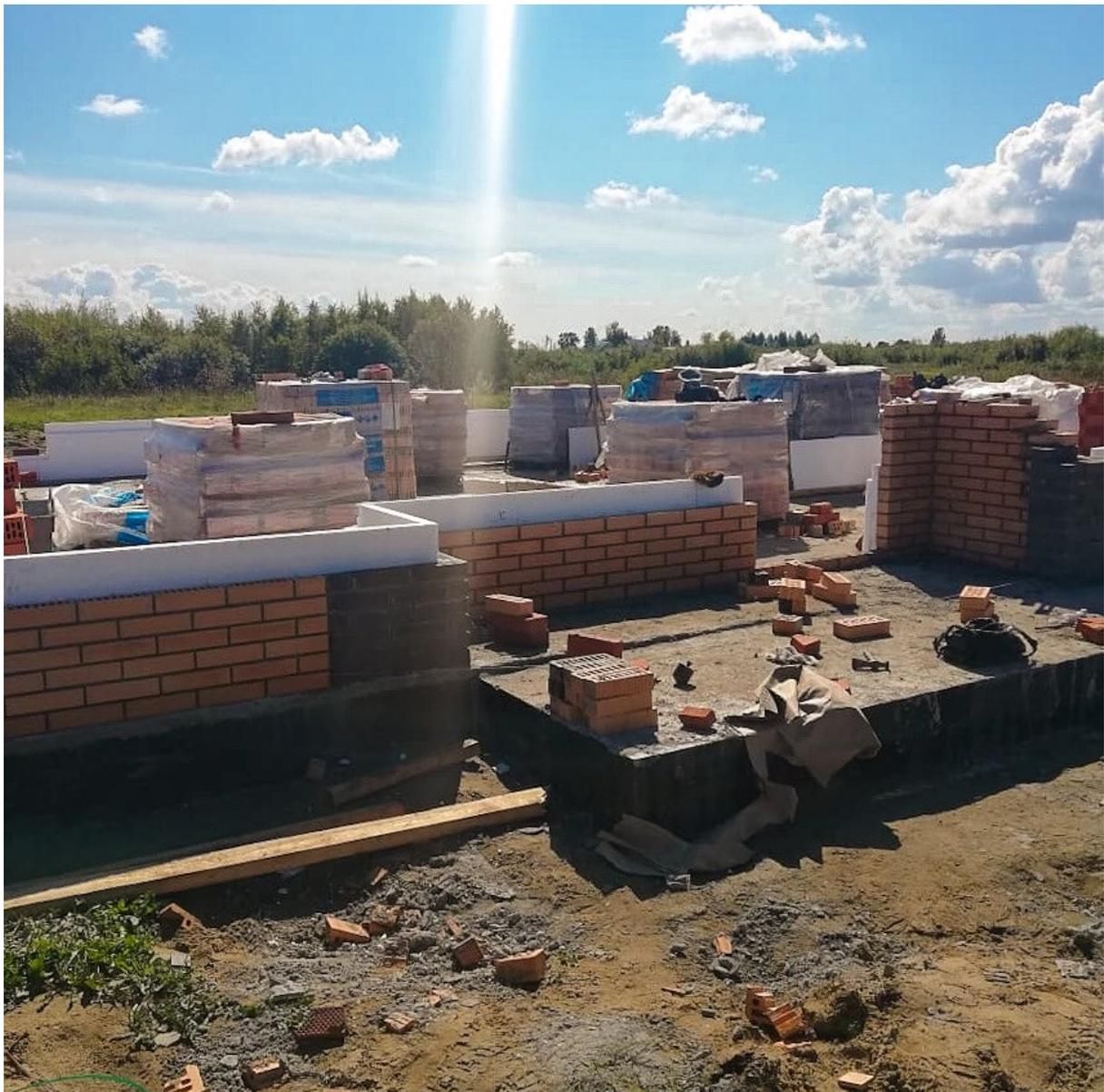
Конечно, вставленный между слоями кирпича пенопласт чуточку исправляет ситуацию. Но не радикально. Все равно в домах будет очень холодно. Но главное - для строительства стен с прослойкой из пенопласта рабочие должны иметь особую квалификацию, так как наружная и внутренние кирпичные стены должны быть качественно связаны друг с другом в сотнях мест. Если этого не сделать (а на строительстве «Заповедного» мы это не увидели), то вскоре стены начнут расходиться, обваливаться и расслаиваться.
