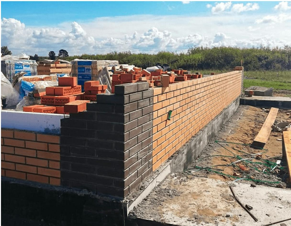
В чем минусы стен по технологии ТИСК? Кирпич - очень плохой материал для строительства. Его единственное достоинство - низкая цена. Кирпич гигроскопичен, он водо- и паропроницаем, его продувает сильным ветром. У кирпича очень низкие характеристики теплоизоляции. Более-менее приемлемые стены в Сибири, если их делать из кирпича в соответствии со СНиПами, должны иметь толщину около двух метров.
