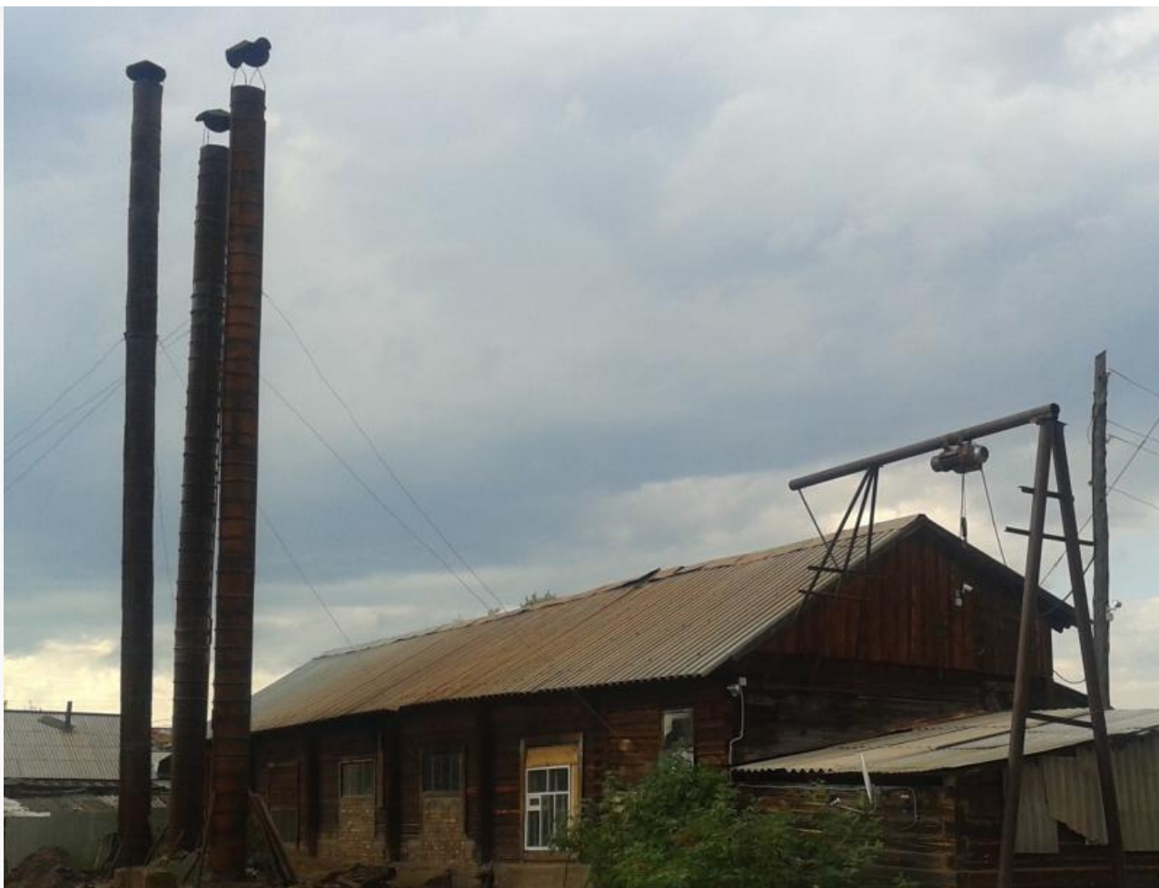
Котельная в Ербогачене
