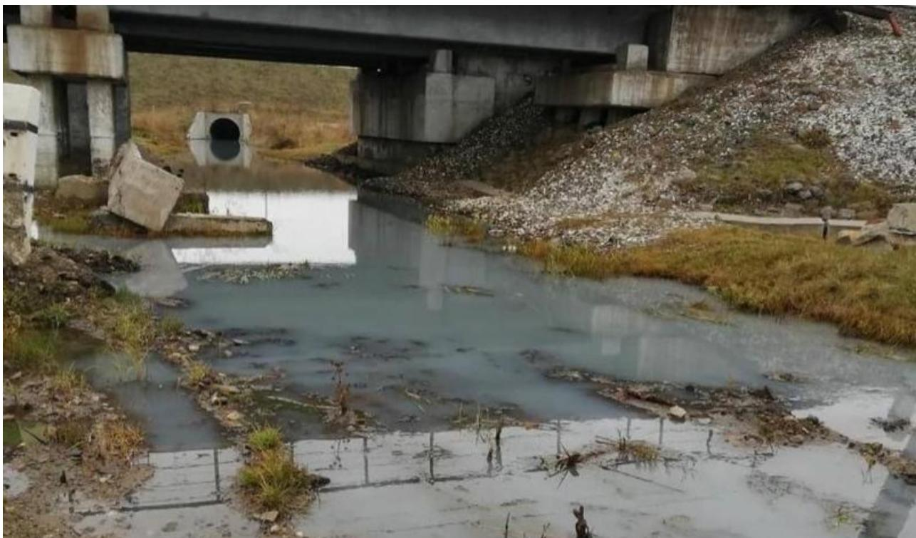
Причиной утечки стал свищ, образовавшийся в шламопроводе, который ведет к шламонакопителю. Поломку уже устранили. Сейчас идет внутренняя проверка, специалисты взяли пробы воды, результаты будут готовы в ближайшее время.
