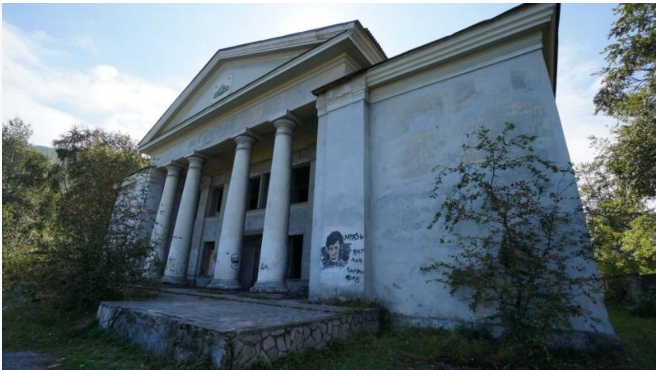
Заброшенный ДК «Горняк». Построен на месте бывшего городского кладбища
