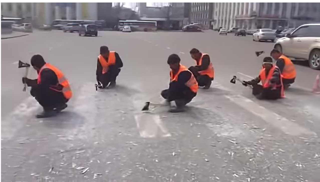
Иркутск, сквер Кирова. Рабочие снимают разметку топорами
