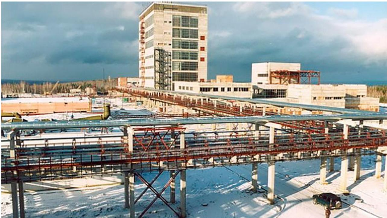
*ЗПК производил полупроводниковый поликристаллический и монокристаллический кремний. Токсичный хлорсилан — продукт этого производства. Для производства кристаллического кремния полупроводникового качества применяется хлоридный метод, при котором порошок технического кремния подвергается гидрохлорированию с образованием хлорсиланов — газообразных хлорсодержащих соединений кремния.*
