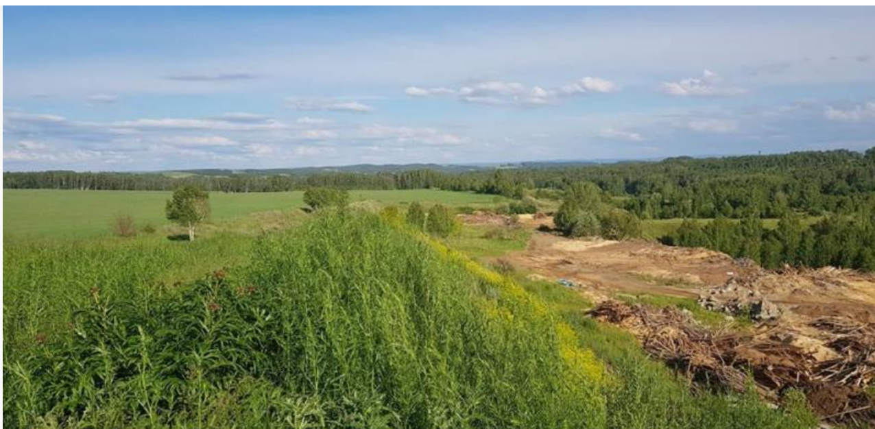
Место под строительство полигона
