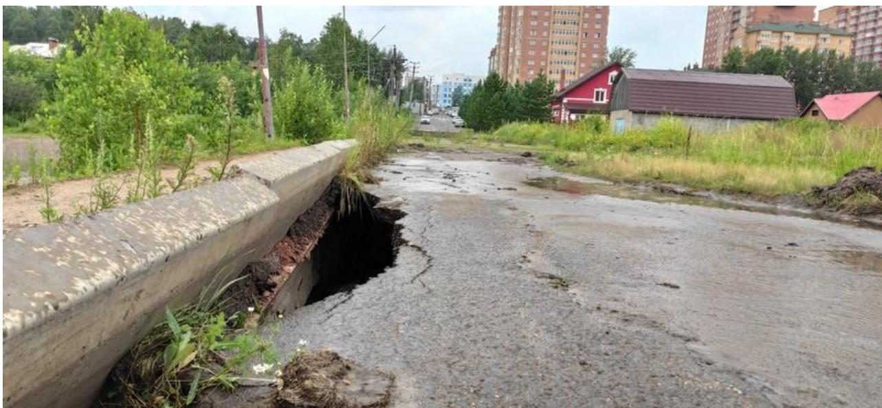
Когда-то по дамбе организовали сквозной проезд автотранспорта, однако сейчас он невозможен: асфальт размыт, зияют ямы глубиной до полутора метров, с одной стороны в озеро заваливаются фонарные столбы. Несмотря на опасность, местные жители продолжают ходить по плотине, так как это кратчайшая дорога до ближайшей автобусной остановки.
