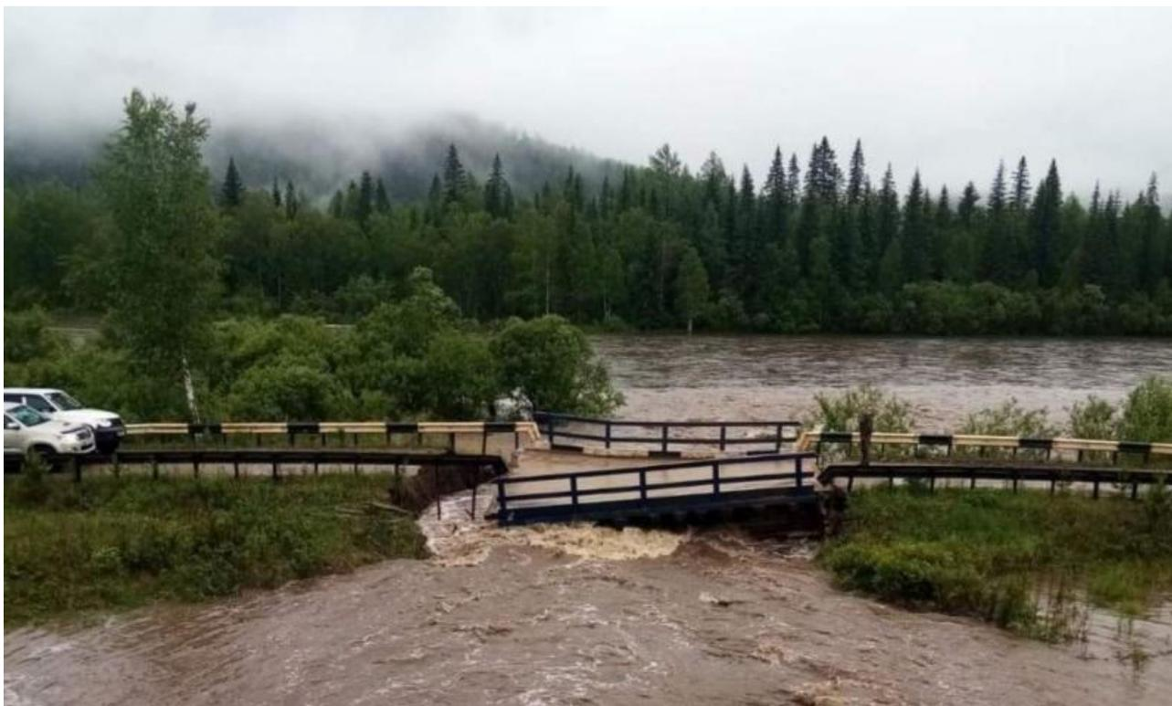
Кроме того, река Мана подмыла железнодорожную насыпь на 708 километре участка железной дороги «Абакан — Тайшет». Движение на участке «Кой – Хабайдак» временно приостановлено, поезда пускают через Ачинск.
