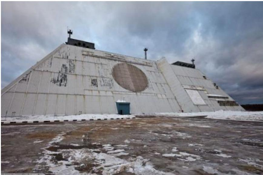
Радиолокационная станция «Дон-2Н» предназначена для обнаружения баллистических ракет, их сопровождения, измерения координат, анализа состава сложных целей и наведения противоракет.
