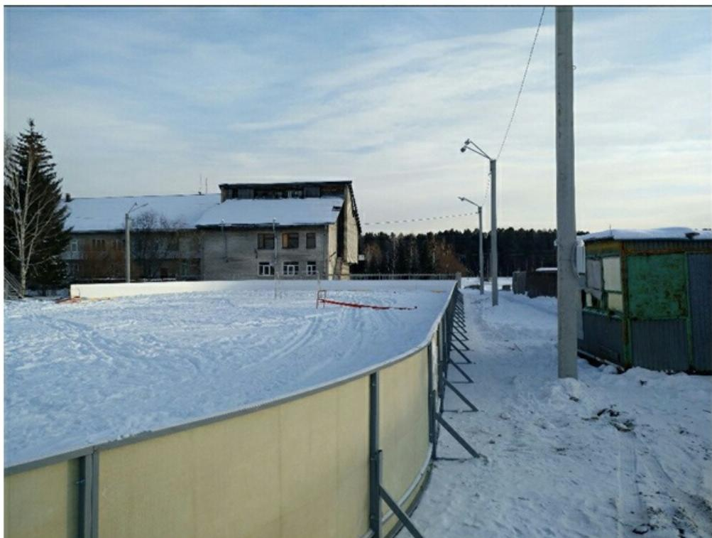
Как мы видим, нет там поручня - «В верхней части борта поручень синего цвета, шириной не менее 45 мм». Нет и сетки высотой 1,5 метра... Хорошо хоть столбы с фонарями поставили. Но обеспечивают ли они требуемое освещение для хоккейных кортов 750 лк на поверхности льда? Сомневаемся что-то...
