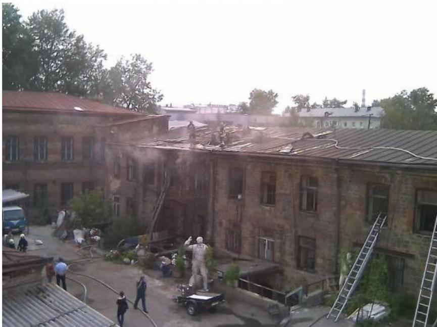
В итоге огонь повредил мебель и перегородки в подвале на площади 30 квадратных метров, перекрытия в подвале на первом и втором этаже, а также перегородки на втором этаже на площади 20 квадратных метров.
