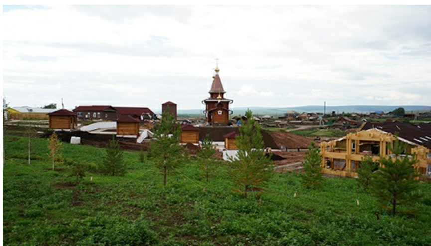
Вид на строительство издалека выглядит даже прилично.
