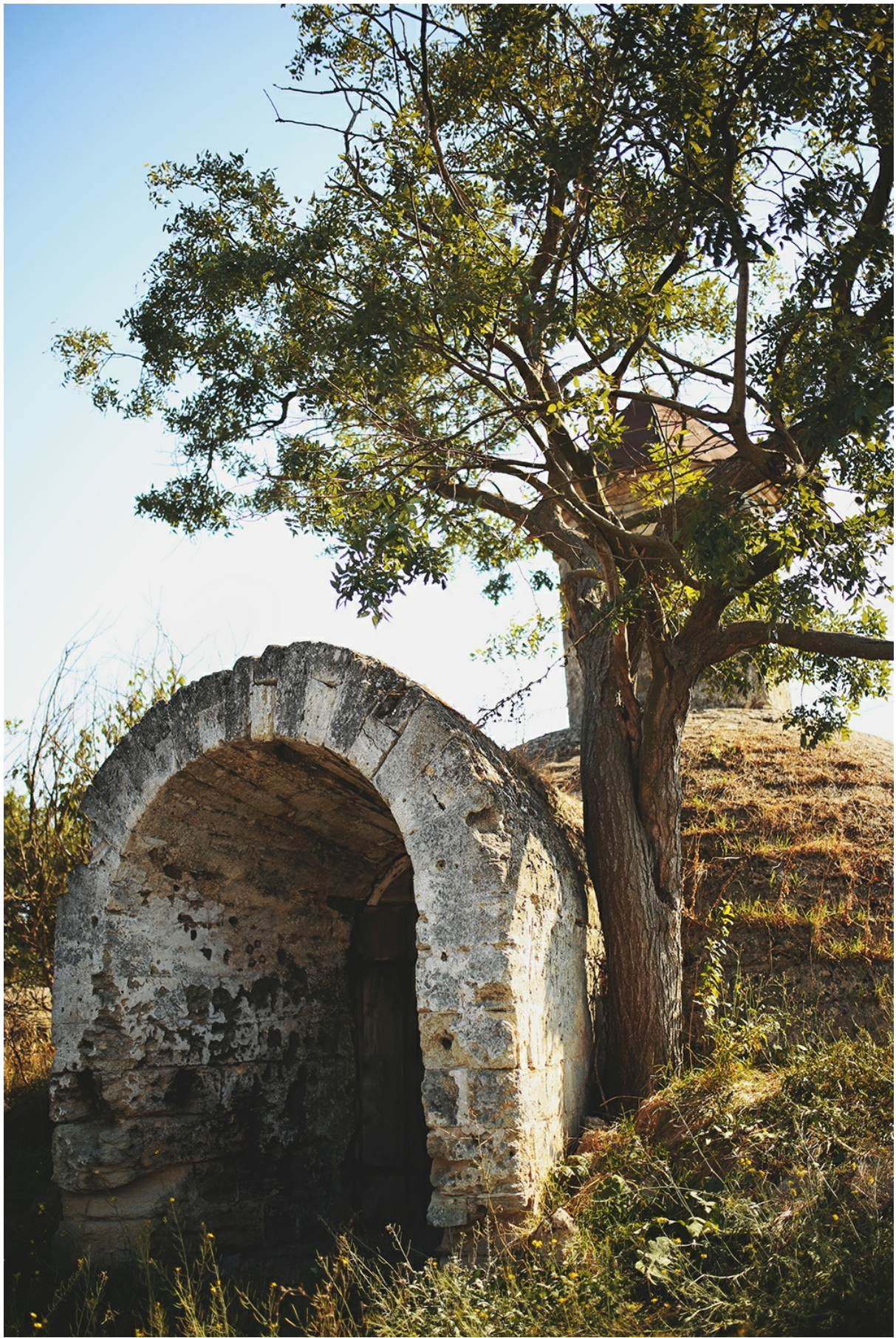
Постройка из ракушечника, близ Азовского моря.
