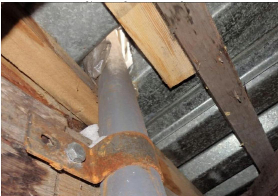
*А вот так смонтированы антенны (вид со стороны чердака). Прделанную в кровле дыру банально заткнули полиэтиленовой пленкой.*
