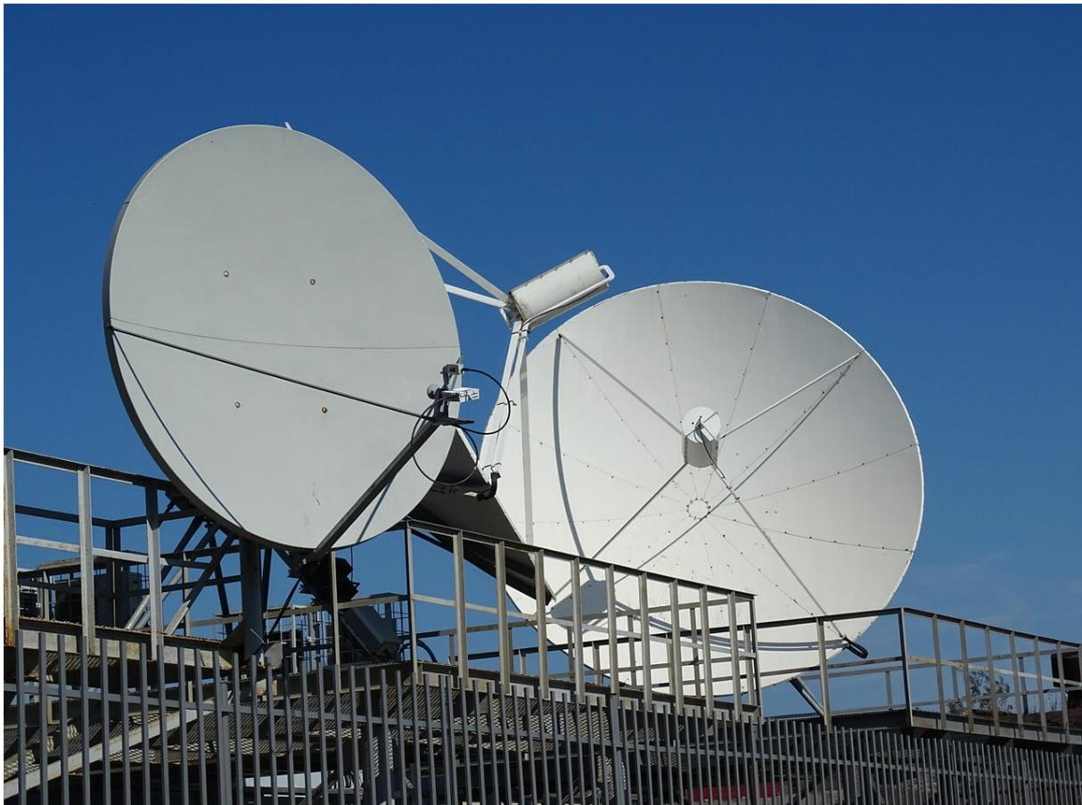
Принимающая/передающая станция Камчатки расположена в пригороде Петропавловска-Камчатского и представляют собой компактный, высокотехнологичный комплекс из антенн и сетевого оборудования. Диаметр тарелок: от 2,4 до 4,5 метров.
